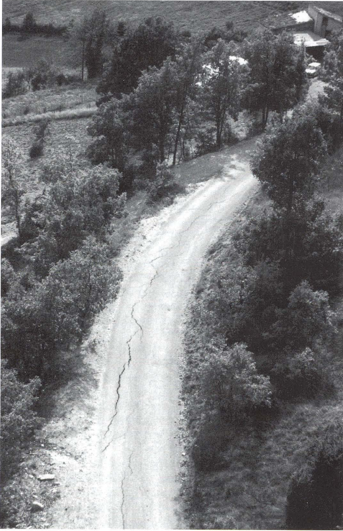
Fig. 4 - Vio. Example of seismically induced ground fractures opened along a road. - Vio. Esempio di fratture al suolo sismoindotte apertesi lungo una strada.
