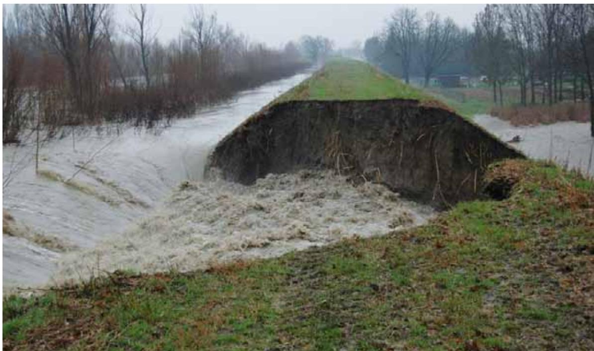
Figura 10. La rottura dell'argine del fiume Secchia nel 2014 (foto AIPo)
